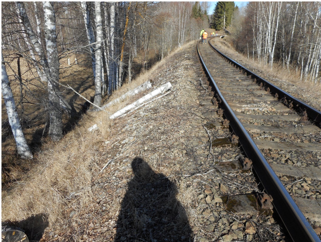
Obr. 1: Šířkově nevyhovující těleso náspu v km 72,450 - pohled po směru staničení
