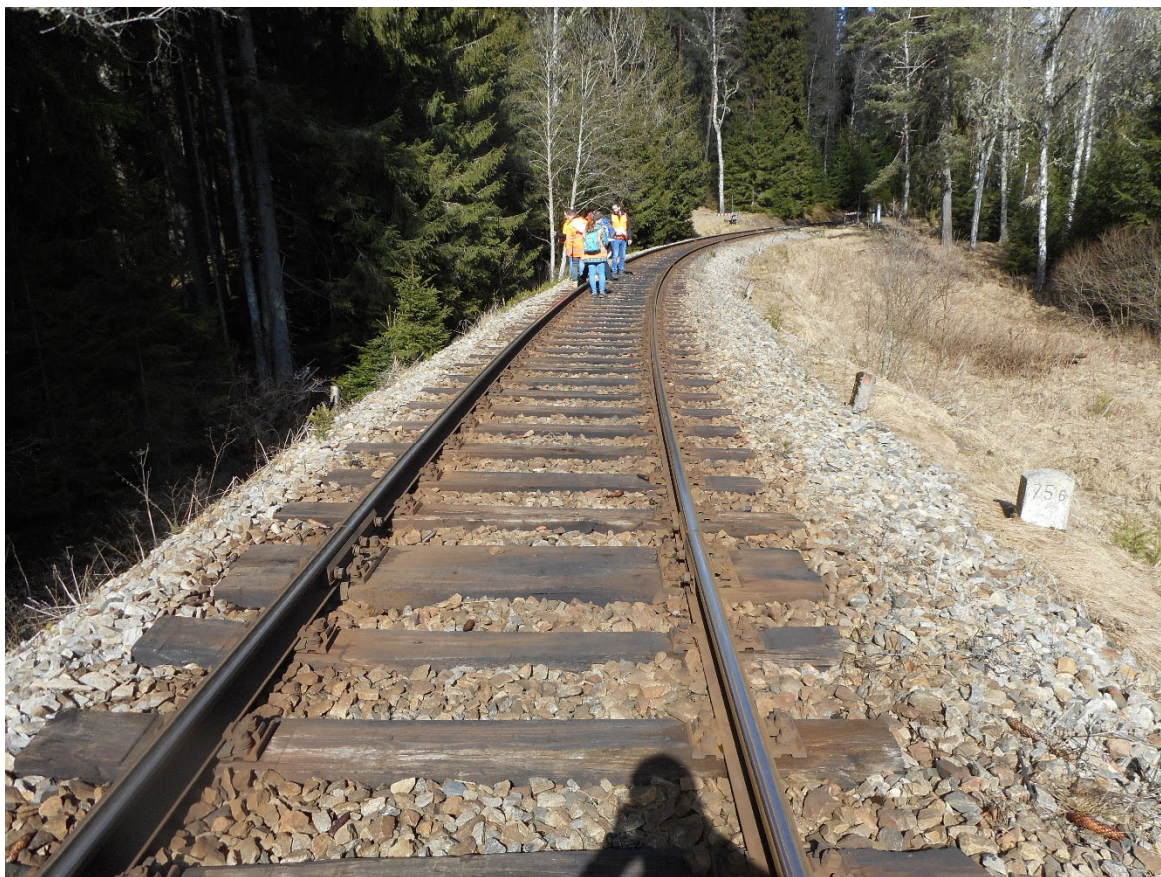
Obr. 10: Šířkově nevyhovující těleso náspu v km 75,600 - pohled po směru staničení
