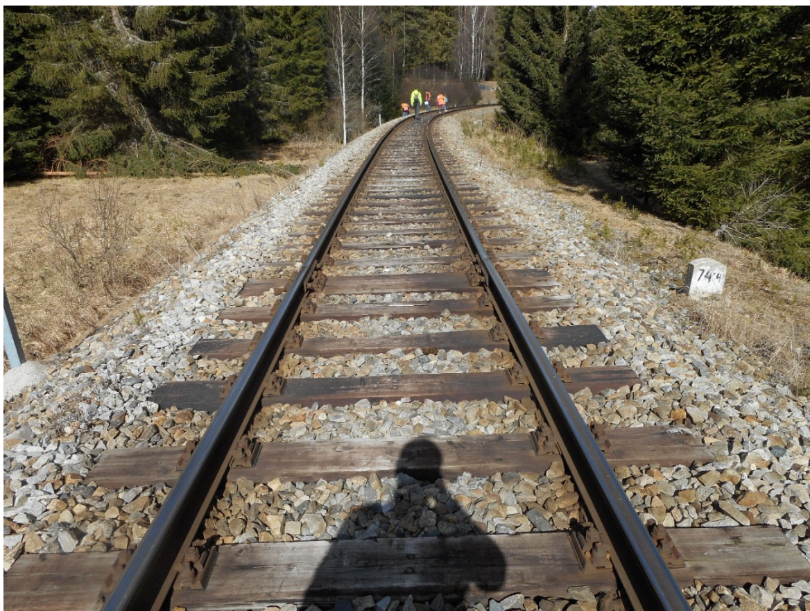
Obr. 7: Šířkově nevyhovující těleso náspu v km 74,450 - pohled po směru staničení
